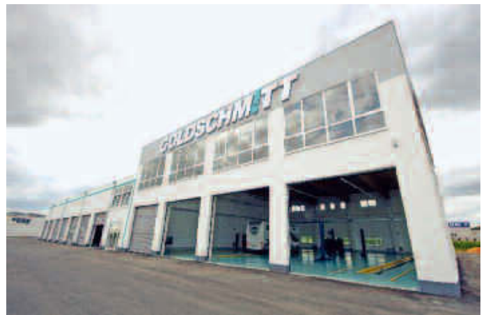
Rund 2400 Quadratmeter misst die Werkstattfläche im neuen GTC.
